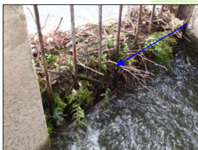
Colmatage des grilles de la prise d'eau entraînant un manque d'eau dans la passe
