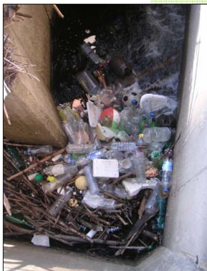
Obturation et colmatage des communications entre bassins
